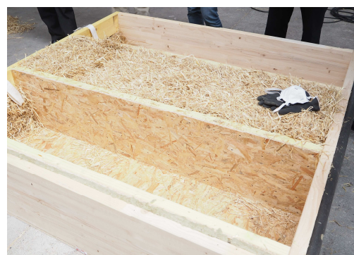
Préfabrication des murs en ossature bois et isolation paille
